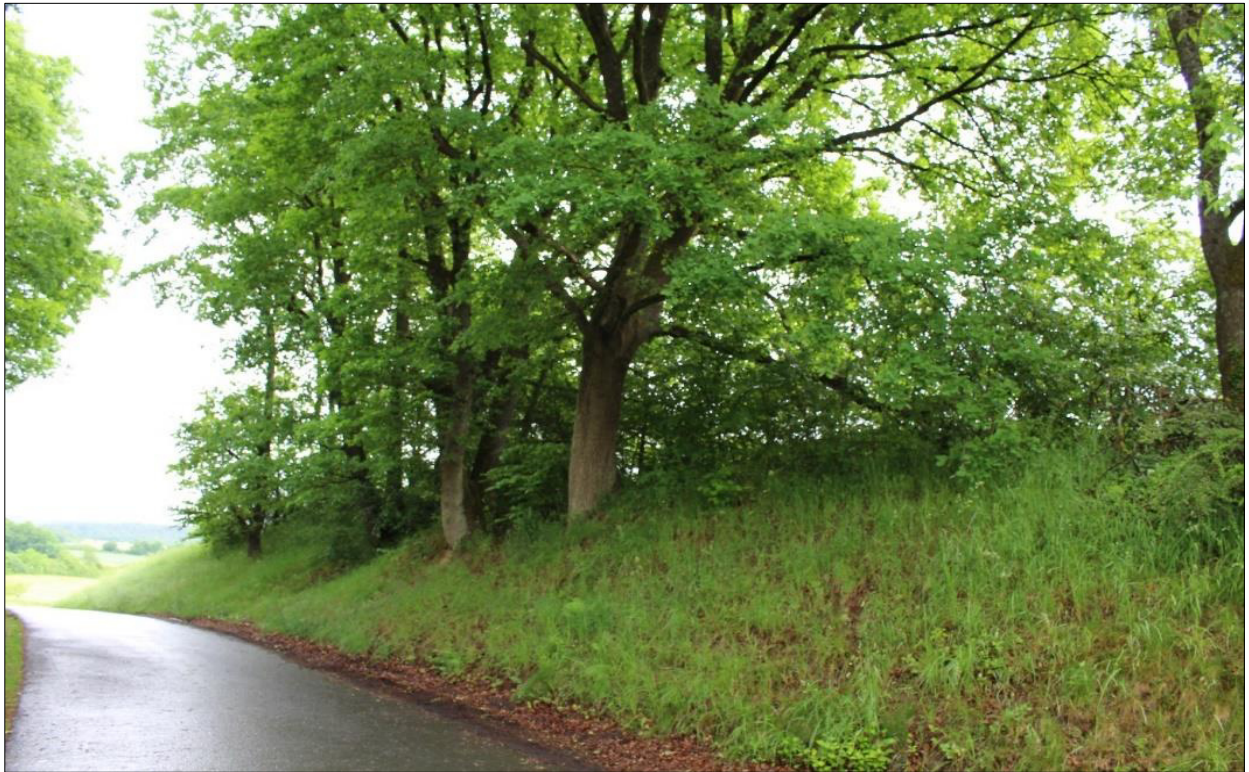
Abbildung 14: Böschung am Rand des Eingriffsgebiets entlang der Brunnenstraße. (Quelle: IBU 24.05.22).
